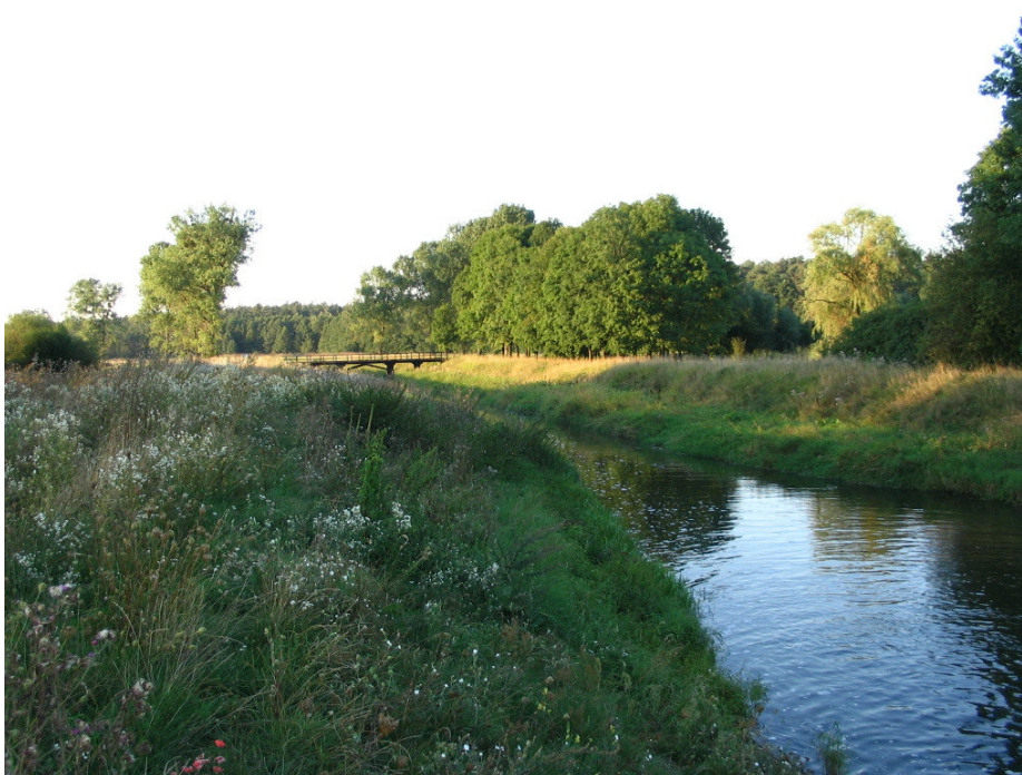
Fotografia 3. Kanał Wieprz-Krzna w okolicach wsi Borowica, początek Kanału, część południowa
