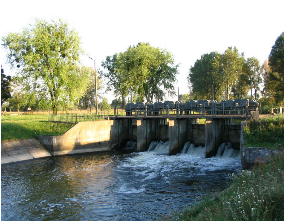
Fotografia 4. Początek Kanału wieprz-Krzna w Borowicy, część południowa
