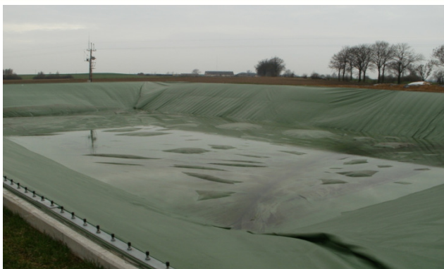
Zakryta laguna przy biogazowni w Skrzatuszu źródło: biogaz.com.pl
