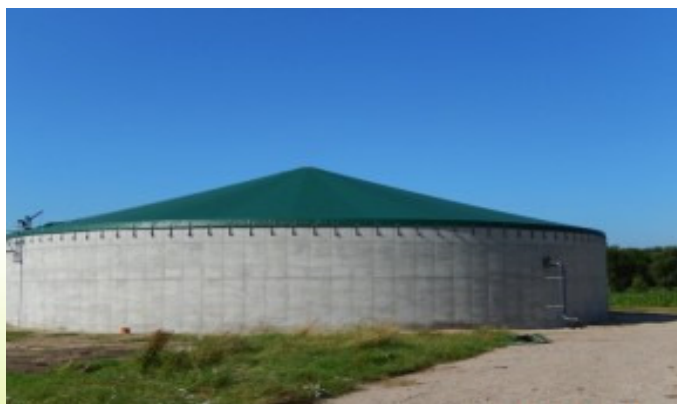
Żelbetowy zbiornik ze stożkowym dachem membranowym źródło: www.wiefferink.nl/silcover.html
