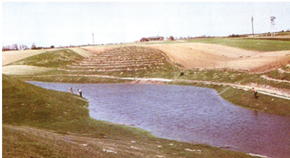
Fot. 3. Zagospodarowanie wąwozu zbiornikiem retencyjnym (Cz. Józefaciuk)
