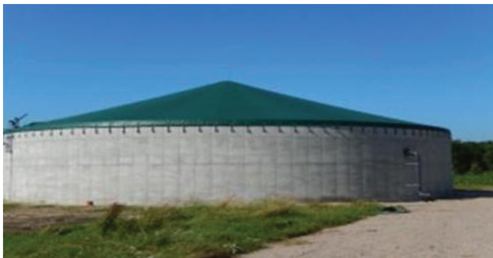
Fot. 1. Zbiornik żelbetowy ze stożkowym dachem membranowym
