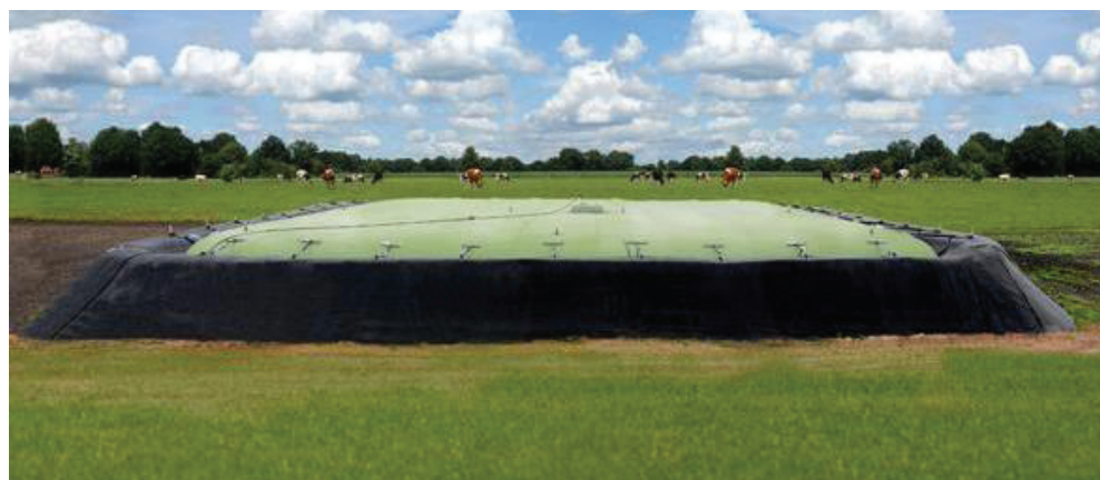
Fot. 3. Zbiornik z elastycznego tworzywa sztucznego ( slurry bag ). Charakteryzuje się stosunkowo niskimi nakładami inwestycyjnymi oraz szybką instalacją
