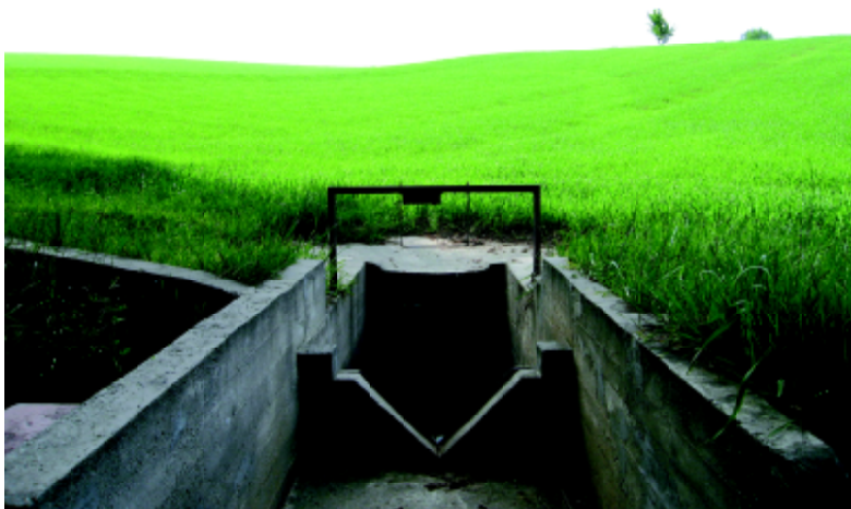
Rys. 5. Przepust przelewowy (konstrukcji E. Nowocienia) u wylotu mikrozelewni w Rogalowie Fot.: J. Jadczyżyn.
