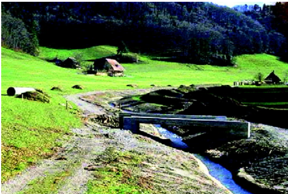
Fot. 2. Renaturyzacja cieków (BLW, 2009 r.)
