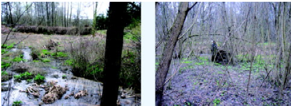
Fot. 4. Zabudowa wąwozu dolinowego zbiornikiem kolmatacyjnym z podnoszonym przelewem odpływowym (fot. B. Podolski, 2010)
