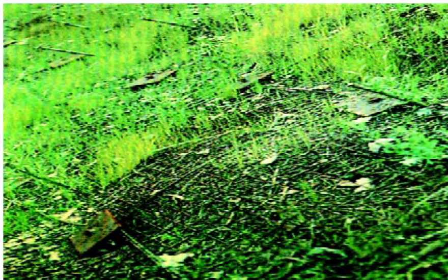
Fot. 9. Zabezpieczenie skarpy przed osuwiskiem metodą siatek stalowych z kotwami w betonie sprężonym (fot. B. Podolski, 2010)
