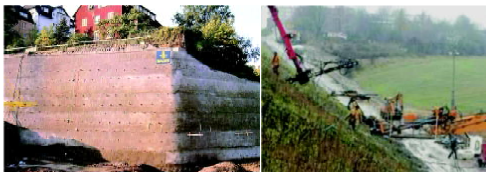
Fot. 10. Umocnienie gruntu zastrzykami z betonu sprężonego (fot. B. Podolski, 2010)
