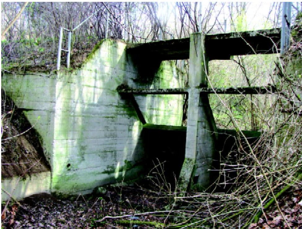
Fot. 2. Jedna z 61 budowli hydrotechnicznych betonowych i żelbetowych, stan z 2010 roku (fot. B. Podolski, 2010)
